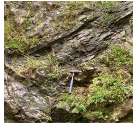
Detalle de un bloque lutítico, plegado por el desplazamiento talud abajo.
