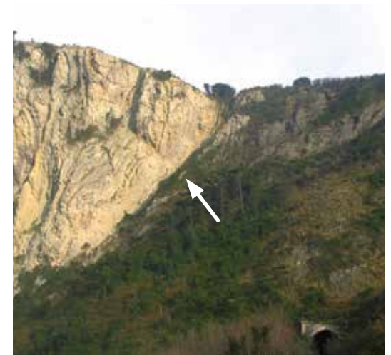
Detalle de la falla de Andutz.
